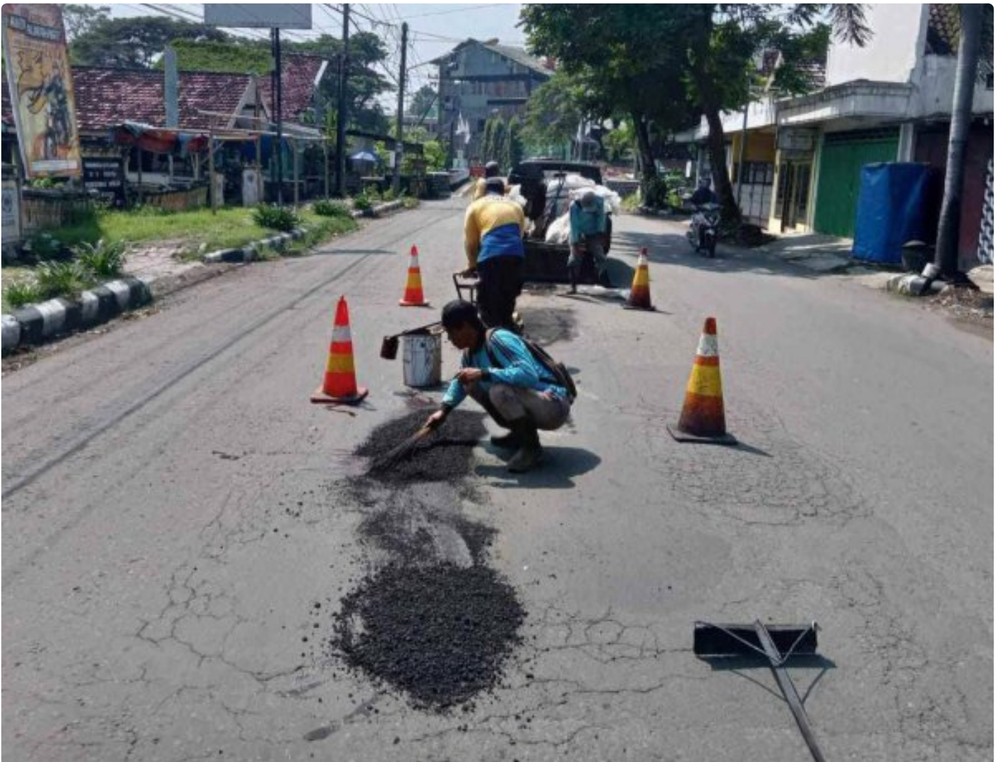
Dinas PUPR Kota Kediri menambal jalan berlubang di sepanjang Jalan Merbabu Mrican
